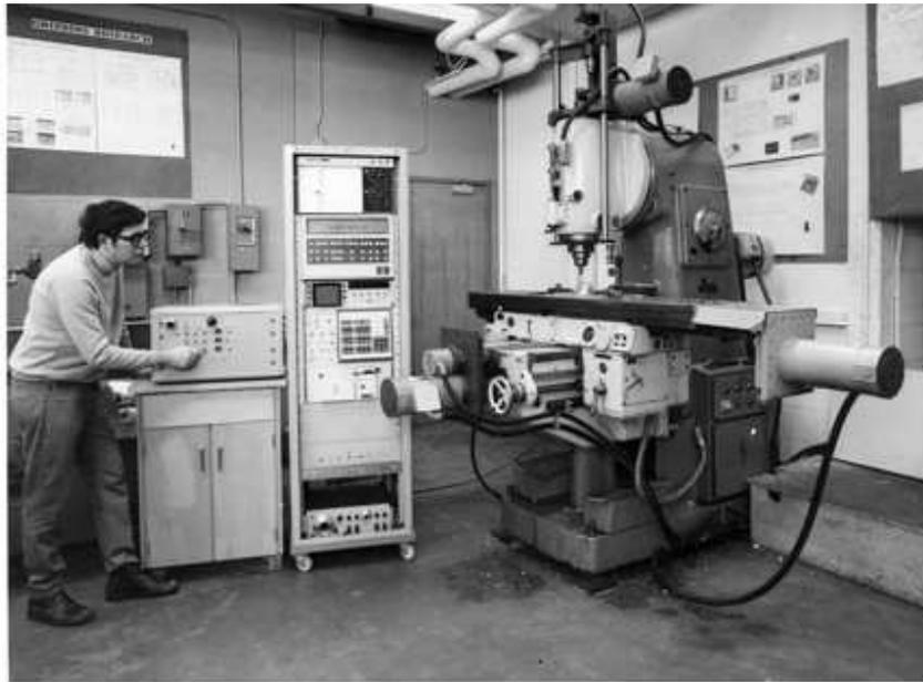
***Figura 1.40. Primera fresadora CNC utilizando para su control una computadora HP-2100, la cual era de 16 bits y 4K en RAM (McMaster University, Hamilton, Canada, Mayo 1973)***
